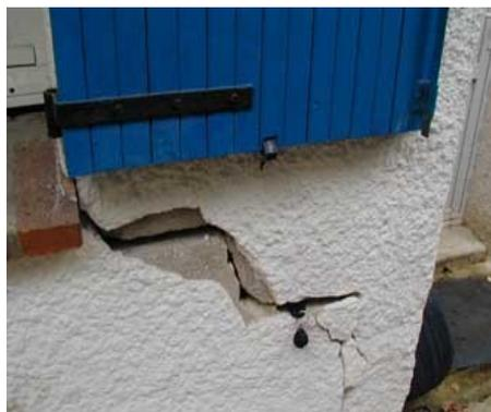
Les dégâts se manifestent aussi par des décollements entre des éléments jointifs (garages, terrasses), une distorsion des portes et fenêtres, une dislocation des dallages et, parfois, une rupture des canalisations.
